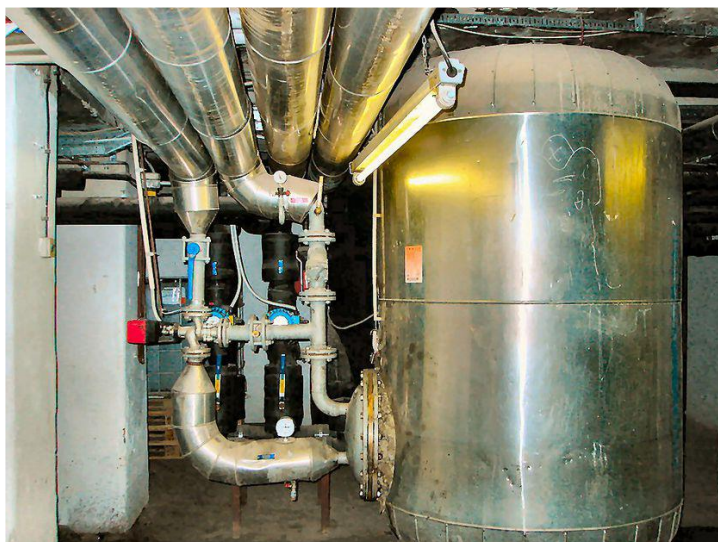
Slika 7: Posnetek zalogovnika TSV stare bolnišnice volumna 5000 litrov
