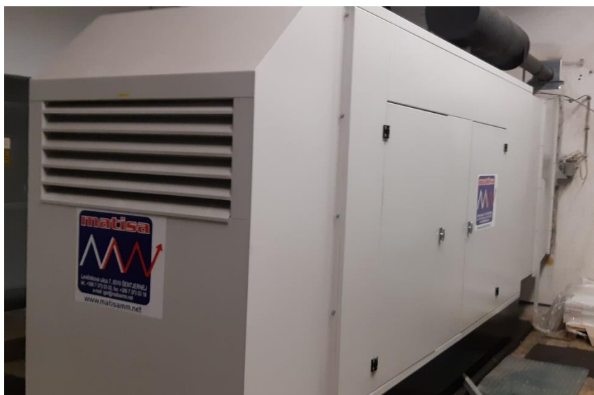
Slika 2: Diesel agregat
