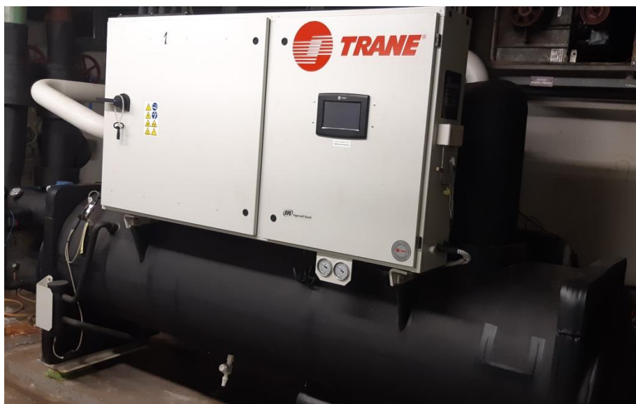
Slika 9: TRANE hladilni agregat
